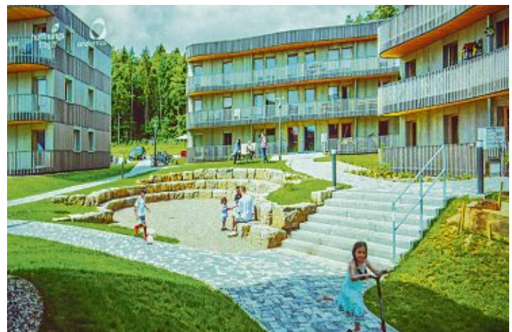
So sieht die Wohnbebauung der Stiftung in Calw-Wimberg aus. Laut Stiftung wird durch die Holzbauweise 75 Prozent CO 2 eingespart. Der Festpreis pro Quadratmeter Wohnfläche liegt bei 3.000 Euro. Die Bauzeit beträgt sechs bis acht Monate. Bild: Stiftung Hoffnungsträger
