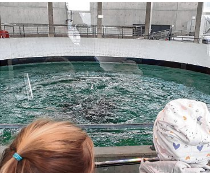
Das Quellbecken war besonders spannend: Hier tritt das Wasser aus dem Bodensee erstmals ans Tageslicht. Das Becken hat einen Durchmesser von 14 Metern und eine Wassertiefe von etwa 3 Metern. Bilder: GS
